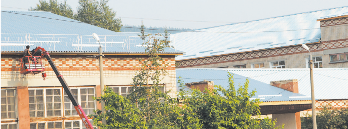
В летний период в школе № 9 заменили кровлю
