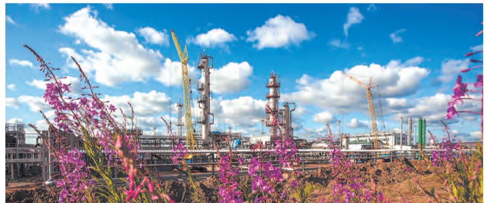
Идет строительство установки подготовки природного и попутного нефтяного газа на Ярактинском месторождении, являющейся частью газового проекта ИНК
