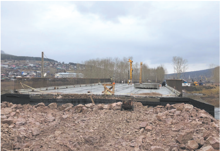
Новый мост через Куту будет с двухполосным движением, длиной 169 метров.
