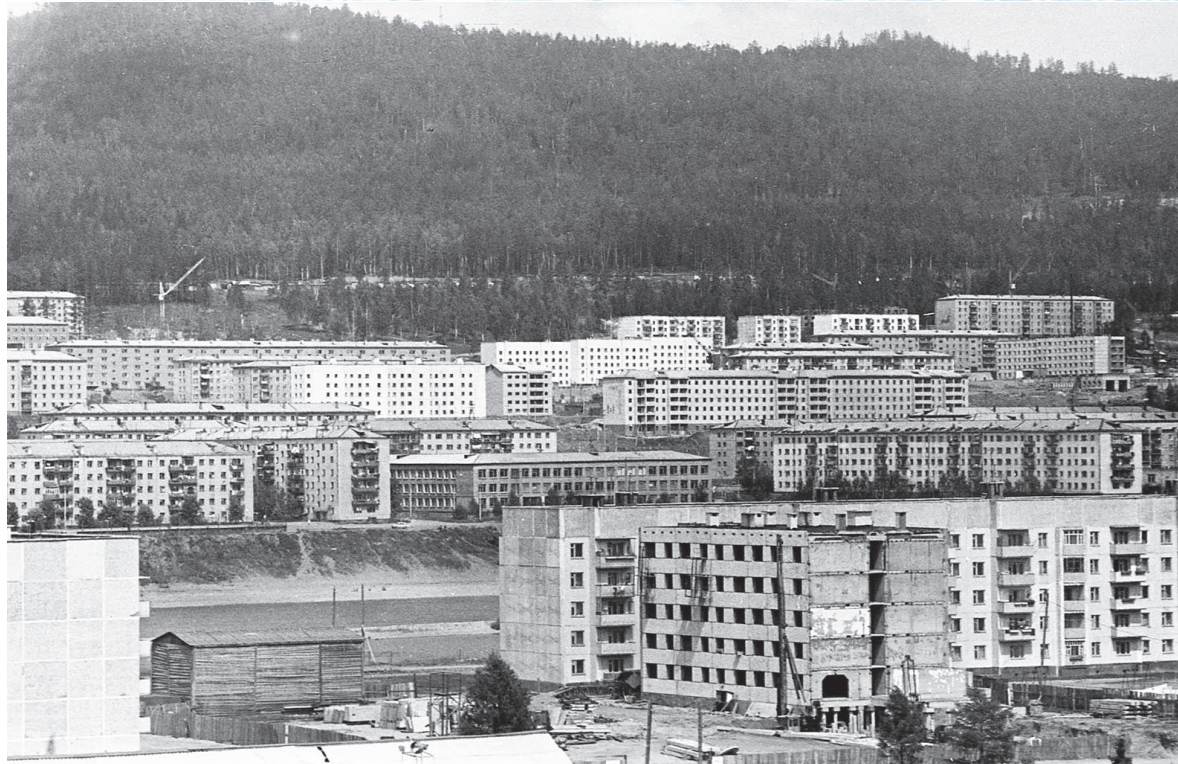
Мкр. Новая РЭБ. Строительство «серой общаги».
