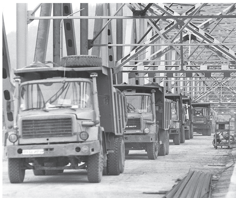
Испытание Магирусами (Magirus-Deutz) автодорожного моста через реку Лену (предположительно 1988 г.).
