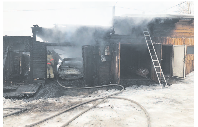
В результате пожара один гараж повреждён во всей площади, во втором – повреждена стена
