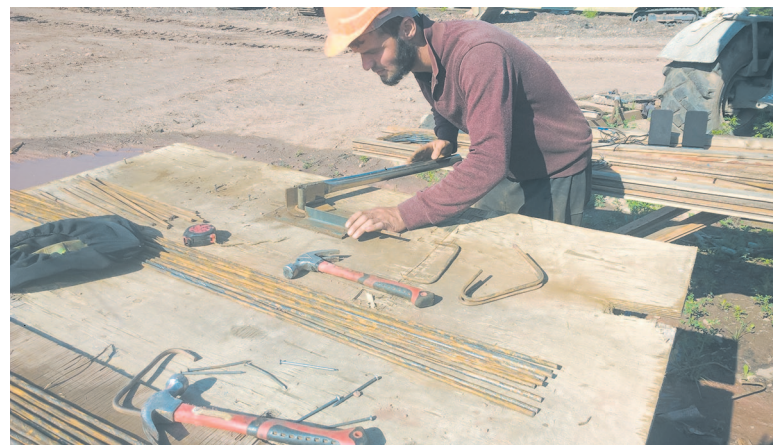
Заготовка материала для арматурного каркаса
