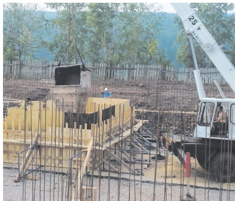
Строители подают бетон для заливки приямка – углубления в земле, примыкающего к стене здания. Здесь будет оборудована водоподготовка.
