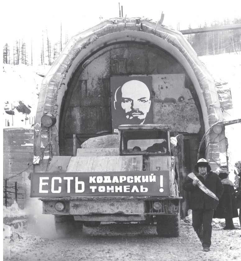
На открытии Кодарского тоннеля
