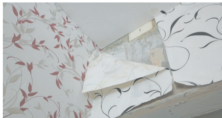
В доме № 11 по ул. Коммунистическая протекает крыша, из-за этого в квартирах на пятом этаже – сырость
