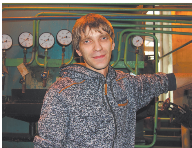
Мастер котельной «Центральная» Алексей Прохорцев
