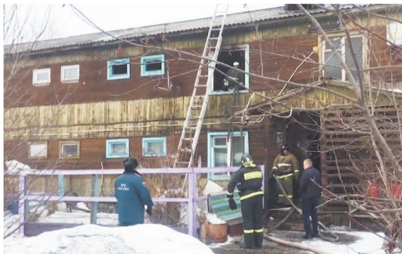
В двухэтажном доме в мкр. «ЯГУ» 17 марта произошёл пожар
