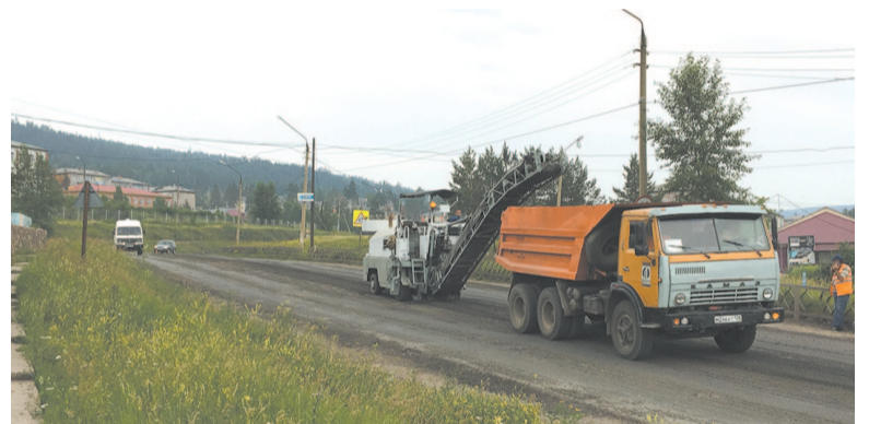
Реконструкция участка от ост. «Строительная» до АЗС
