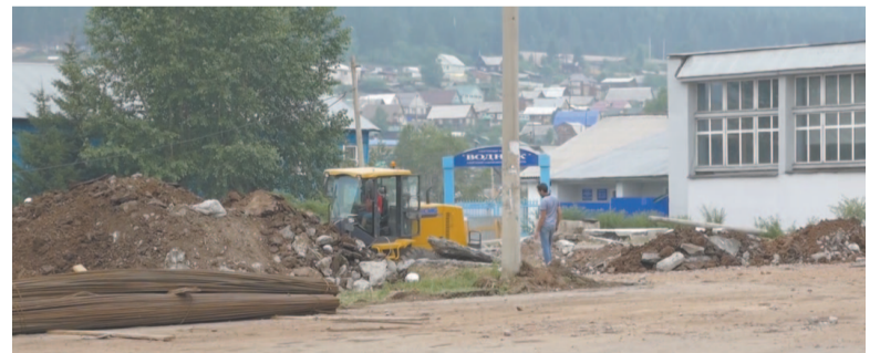
Ремонтные работы на площади у стадиона «Водник» в самом разгаре
