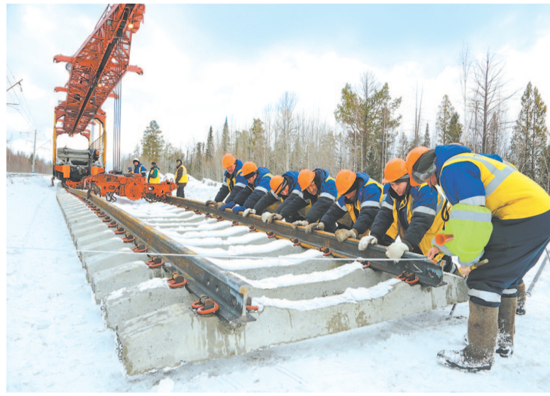
Строительство вторых железнодорожных путей
