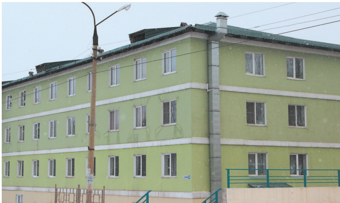
В доме по улице Речников, 16, после жалоб жильцов проводился ремонт
