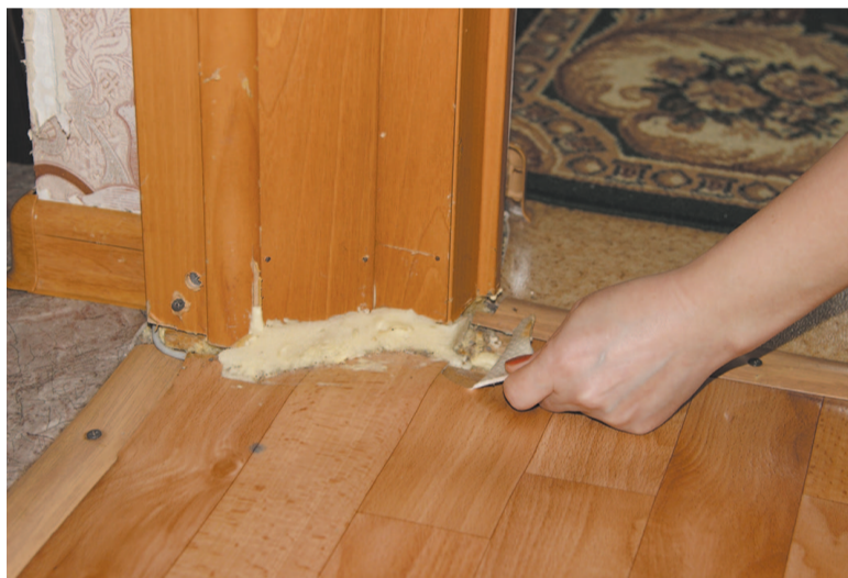
Щели между стенами и полами приходится заделывать строительной пеной
