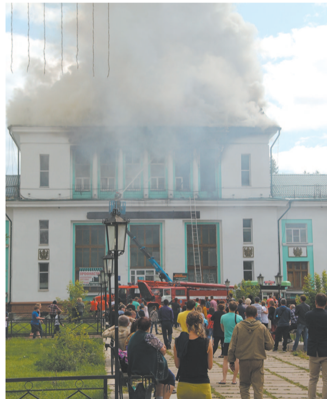
Накануне произошёл пожар в здании водного вокзала.
