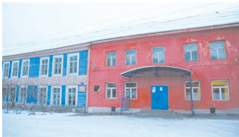
Следователи предполагают, что строительство этой школы прошло со значительными нарушениями.
