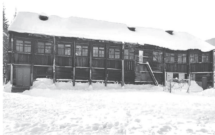
Многолетняя эпопея со строительством новой школы № 7 должна завершиться в 2024 году.
