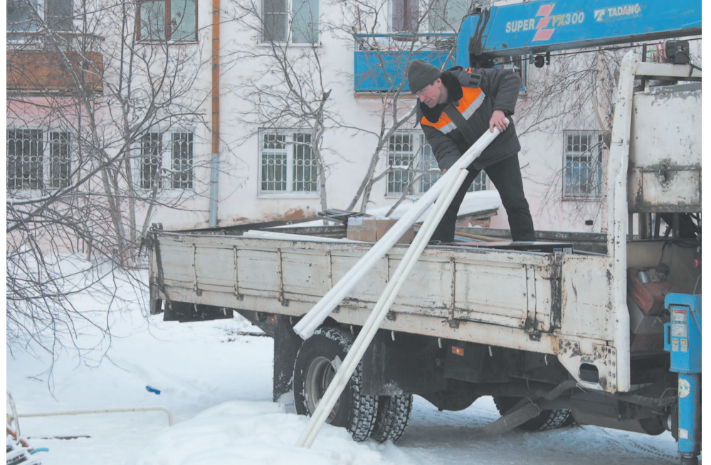
Рабочие трудились в мкр. «Нефтебаза» сутки напролет, чтобы скорее отремонтировать трубы.
