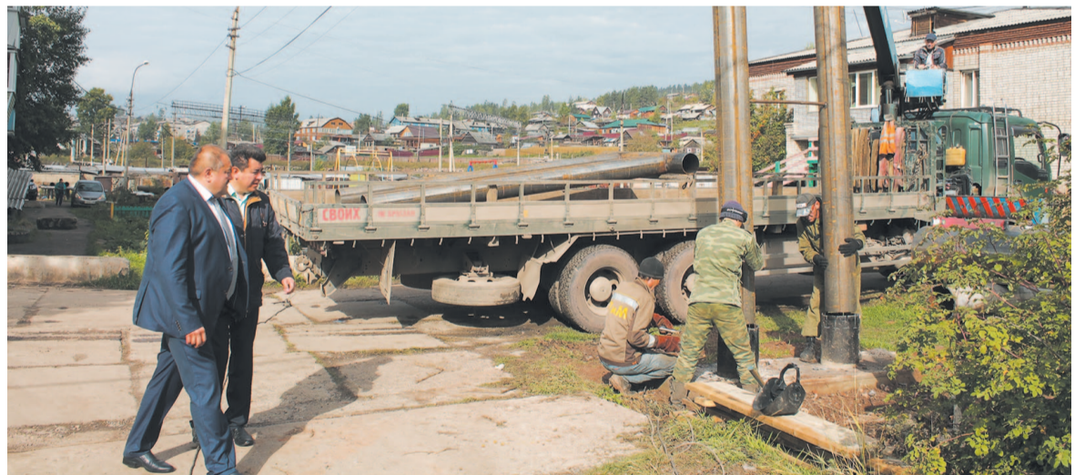
Ремонтные работы теплосети в микрорайоне Нефтебаза находятся на контроле главы города
