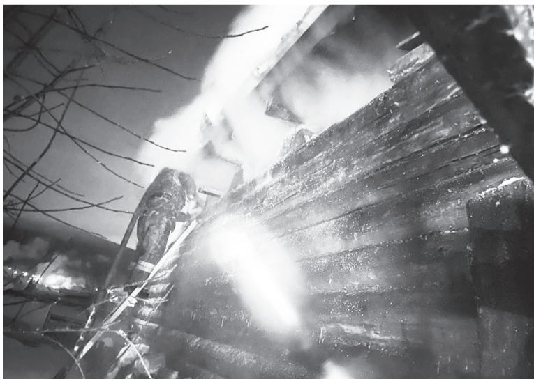
В результате возгорания гараж поврежден на площади 60 кв. м.
