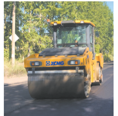
Одновременно идут и укладка нового асфальта, и ямочный ремонт.
