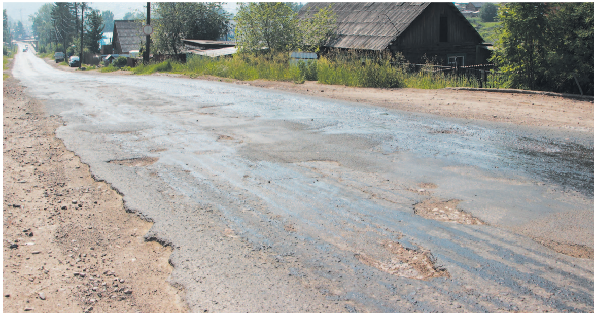
Сотрудники «Автодора» пояснили, что для нанесения разметки сначала ремонтируют середину и край проезжей части, но на улице Некрасова после ремонта в этих местах остались ямы
