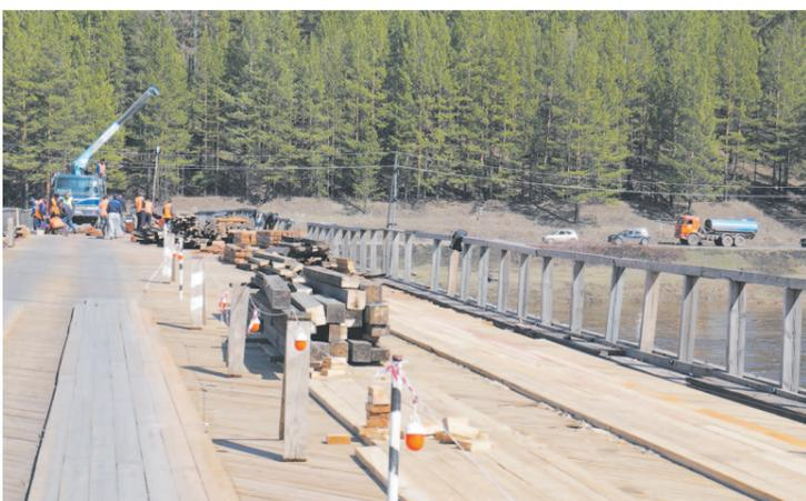
Нарушение графика перекрытия проезда по мосту через реку Куту из-за ремонтных работ стало причиной километровых пробок. Подрядчик ООО «Высота» объясняет это различными факторами. Один из них – при вскрытии защитного и рабочего настилов в основании обнаруживается слишком много сгнивших прогонов, подлежащих обязательной замене. К тому же перед укладкой необходимо очистить площадку от древесной струхи. При работах по замене деревянных конструкций используется спецтехника.
