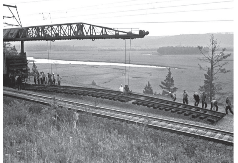
Укладка железнодорожного полотна.
