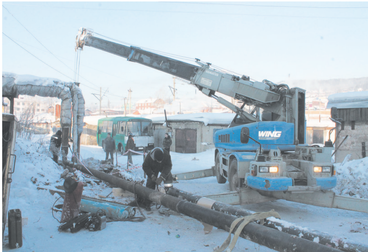
Утепление труб на «Нижней Нефтебазе».
