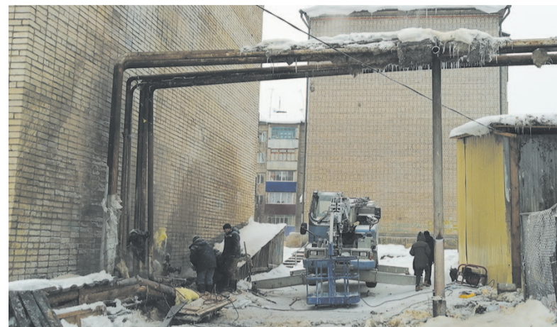
Ведутся работы возле дома по улице Нефтяников, 1А.
