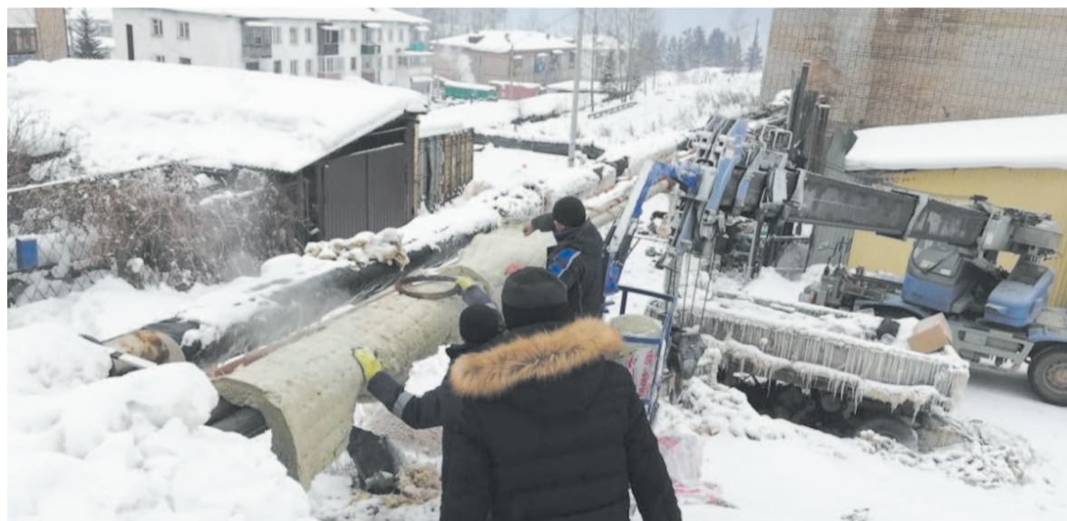
Специалисты оперативно заменяли поврежденные участки теплотрассы.
