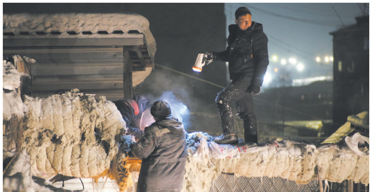
Аварийно-восстановительные бригады устраняли коммунальную аварию круглые сутки.
